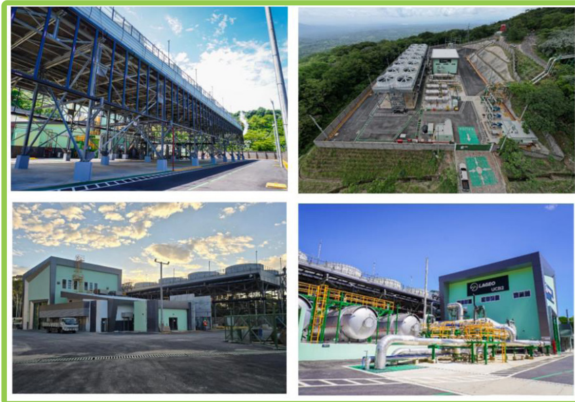
Construcción de obras civiles y montaje electromecánico en Unidad de Ciclo Binario 2.
