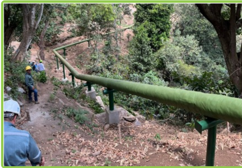
Montaje de soportería y tubería de acero al carbono para línea de reinyección.
