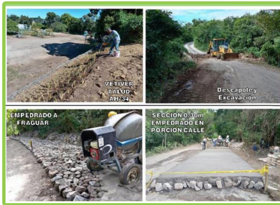
Proceso Constructivo – Empedrado Fraguado y Obras Complementarias.
