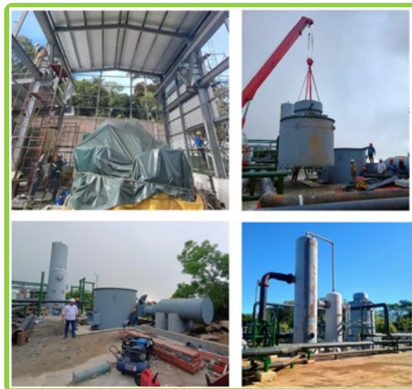
Construcción obra mecánica y montaje de equipos en casa de máquinas plataforma CHI-3.
