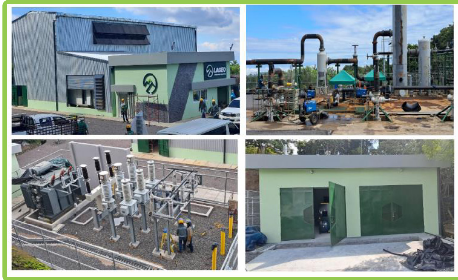
Construcción de Planta Bocapozo y obras complementarias
