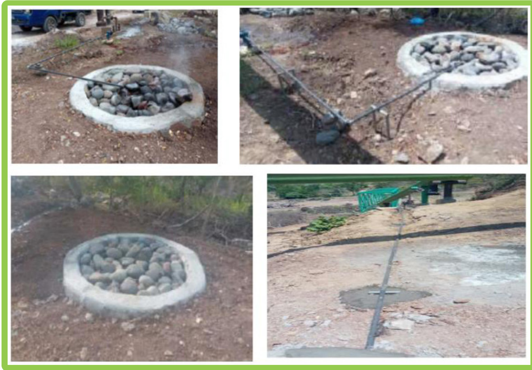
Proceso Constructivo – Empedrado Fraguado y Obras Complementarias.
