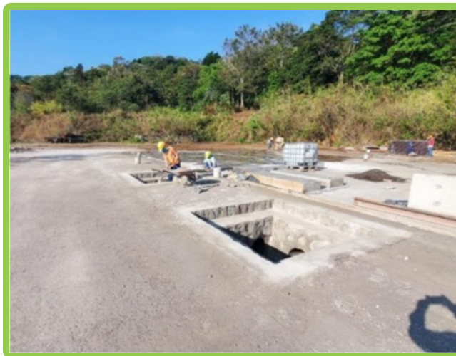
Construcción de dos contrapozos en plataforma CHI-7.
