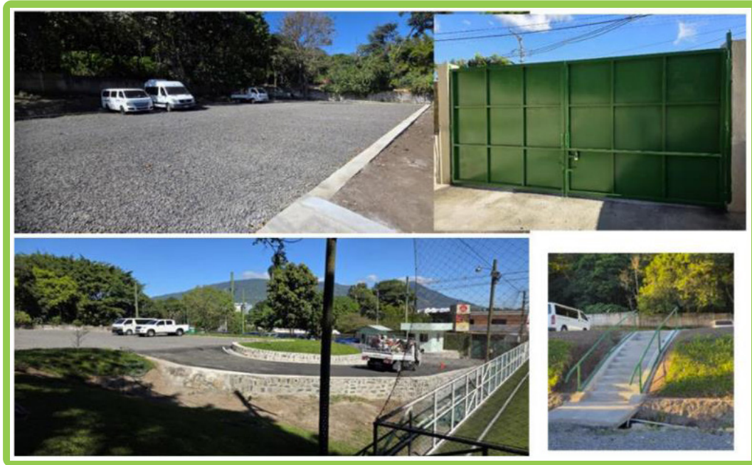
Construcción caseta de vigilancia, accesos y terraza secundaria para estacionamiento vehicular.
