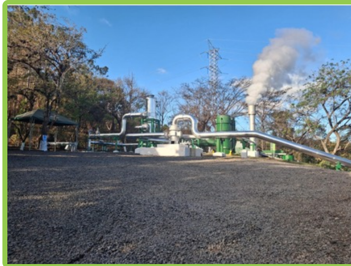
Montaje del sistema de separación en la plataforma del AH-8.
