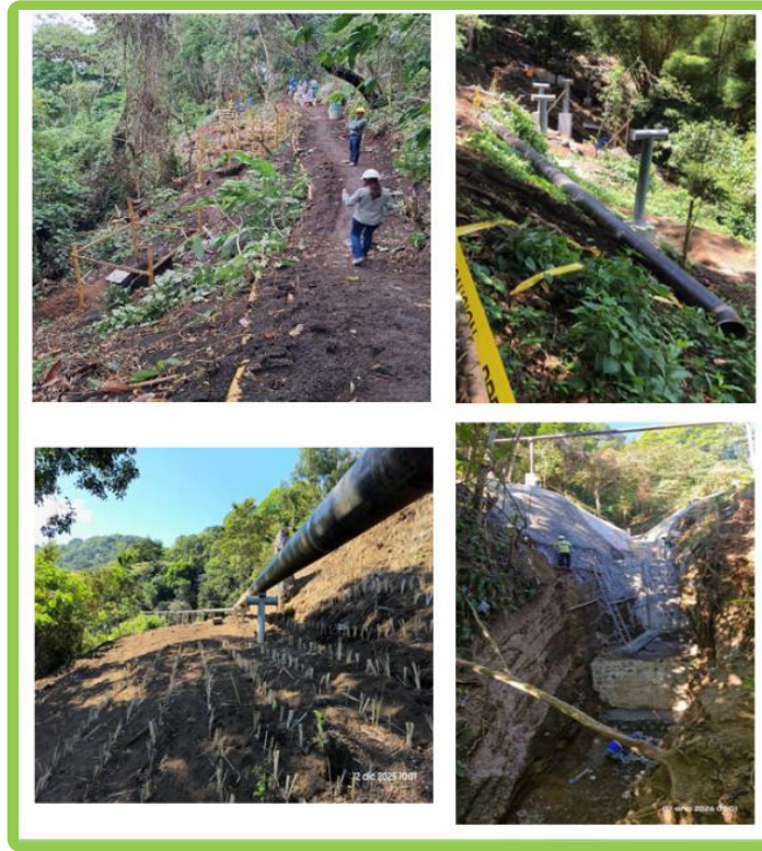
Construcción de bases de concreto, soportes metálicos y obras de protección; montaje de tuberías para el proceso reinyección.
