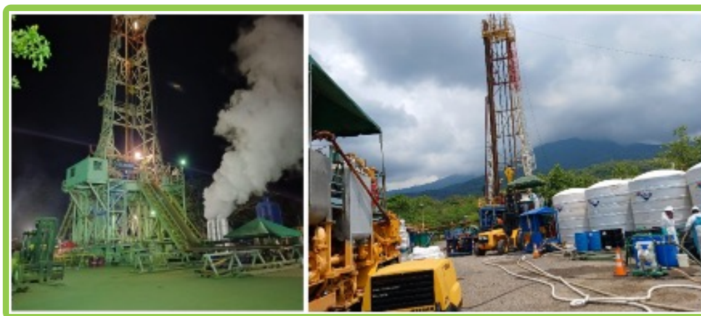
Monitoreo ambiental durante intervención mecánica y estimulación químicas de pozos geotérmicos productores y reinyectores.
