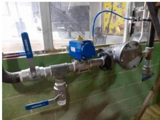
Ilustración 2 Medidor de flujo de melaza de pistón oscilante.
